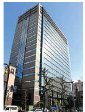
建設技術研究所外観(同社提供)
