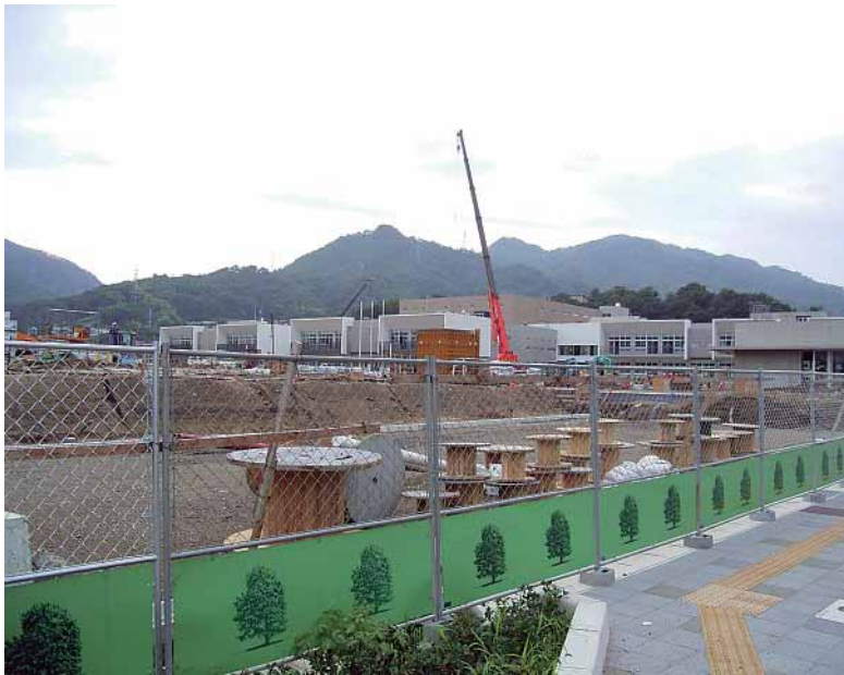
来年4月開講に向け工事が急ピッチで進む
