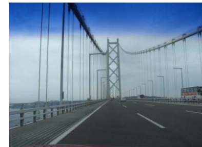
明石海峡大橋
