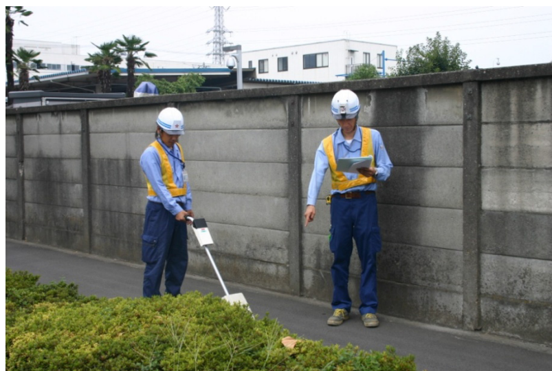
ガス導管漏洩検査
