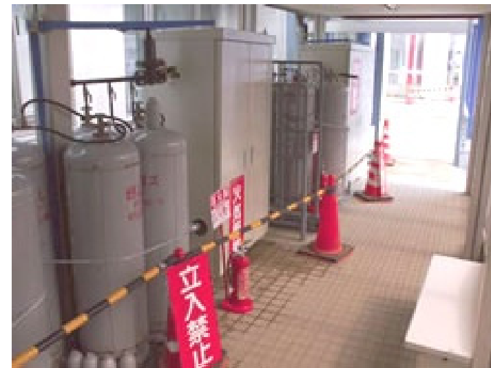
新潟県中越沖地震後、ガス復旧のため柏崎市内の 病院に設置された弊社開発「移動式ガス発生設備」
