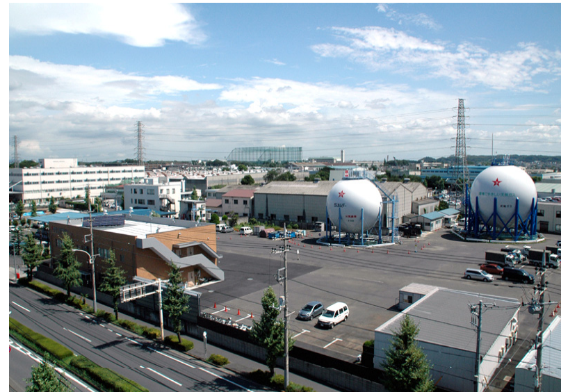
羽村供給センター
