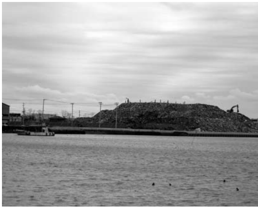
瓦礫の早期撤去が復興のカギを握っている(川口町の一次仮置場)
