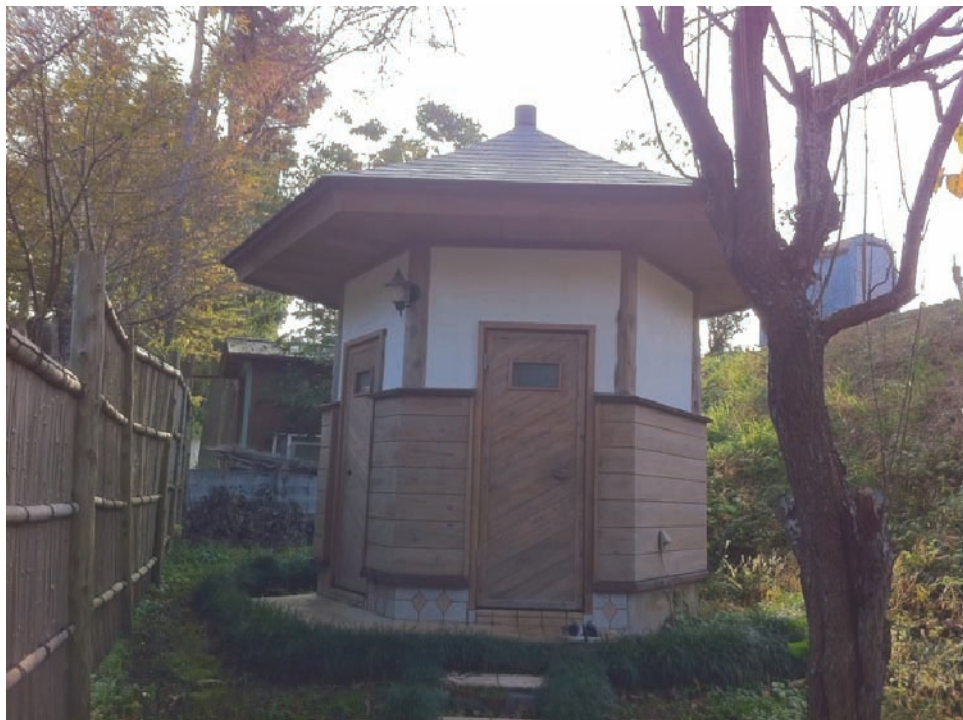
敷地内にシンボルとしてつくられた六角堂。5年間の期間を通じて、タイル張りから、屋根ふきまで全て会員によってつくられた。さまざまな工程を経験することでボランティア活動に活かされるという。(撮影：筆者)
