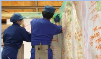
▲ 住環境計画科 (断熱施工実習)
