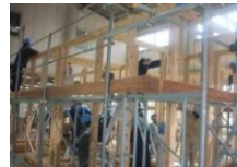
住宅施工技術科(模擬 家屋施工実習の様子)
